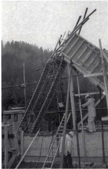
Schalung und Armierung der Fachwerkstreben Struts, formwork and reinforcement
