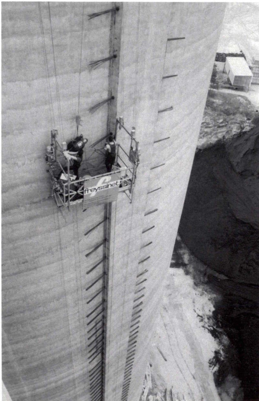
Mise en tension des câbles à partir d'une nacelle suspendue à la paroi
