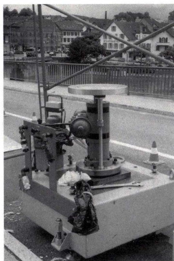
Fig. 4: Der servohydraulische Schwingungserreger (hier noch im Montagezustand ohne Zusatzmasse auf der Kolbenstange). Fig. 4: The servohydraulic vibration generator installed on the bridge (the additional mass has not yet been fixed to the piston rod tip).
