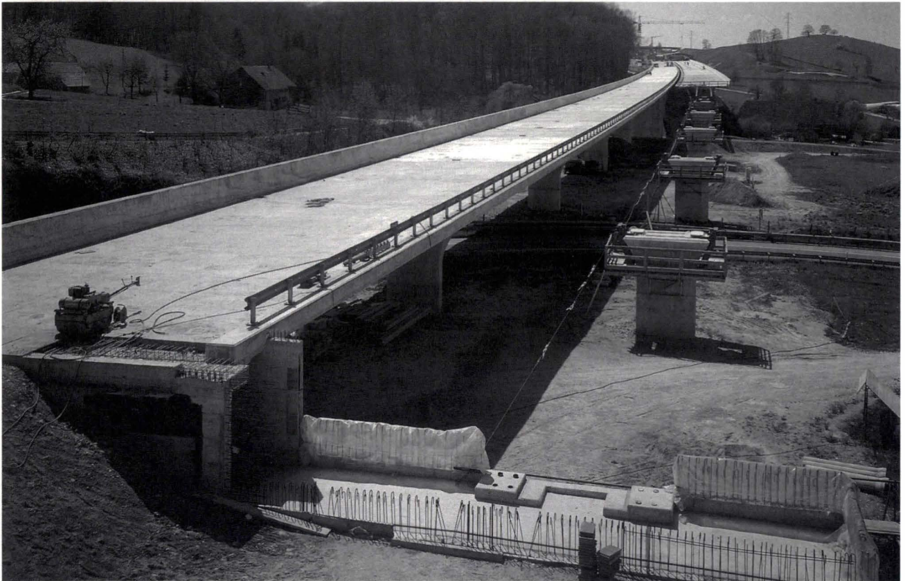
Le gros oeuvre du premier pont exécuté The first outside finish bridge executed
