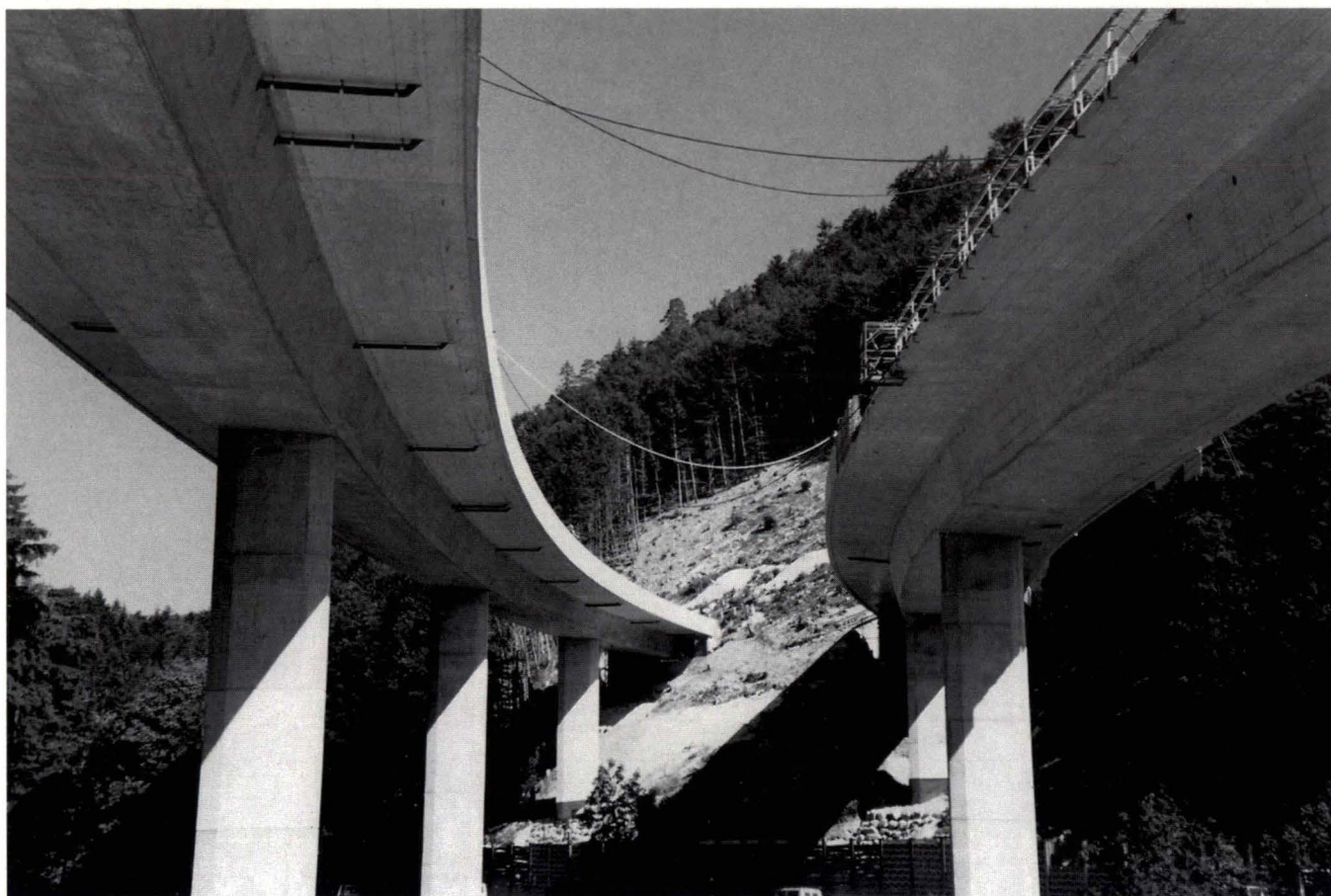
Viaduc de la Suze Flanc nord du vallon, axe 6 terminé, parapets en construction sur l'axe 4 Suze viaduct North flank of valley, section 6 completed; parapets under construction on section 4
