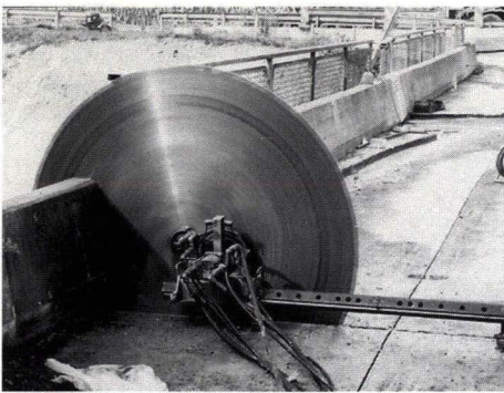
Fig. 2: Trennen des vorgespannten Brückenüberbaus mittels Säge Fig. 2: Dismantling of the prestressed concrete superstructure by sawing
