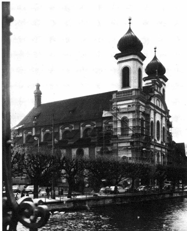
Fig. 1. Vue de l'église. L'échafaudage de la tour sert à la préparation des niches et à la mise en tension des câbles
