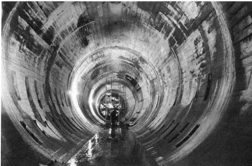
Fig. 6. Tronçon A après bétonnage
