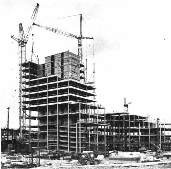
Bild 20. Montage Einkaufszentrum Wallisellen. Links Hochhaus mit vorfabriziertem und vorgespanntem Kern
