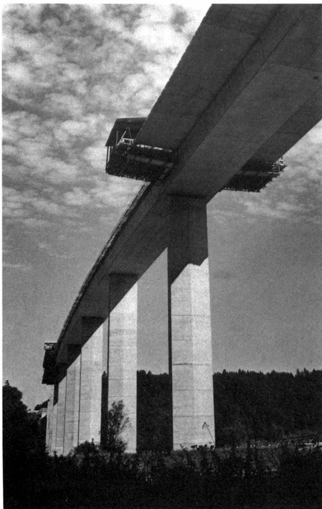
Bild 7. Saaneviadukt Gümmenen. Betonieren der weit auskragenden Fahrbahnplatte mit Hilfe eines Schalungswagens
