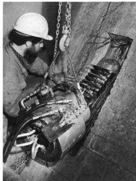
Fig. 7. Mise en tension des câbles
