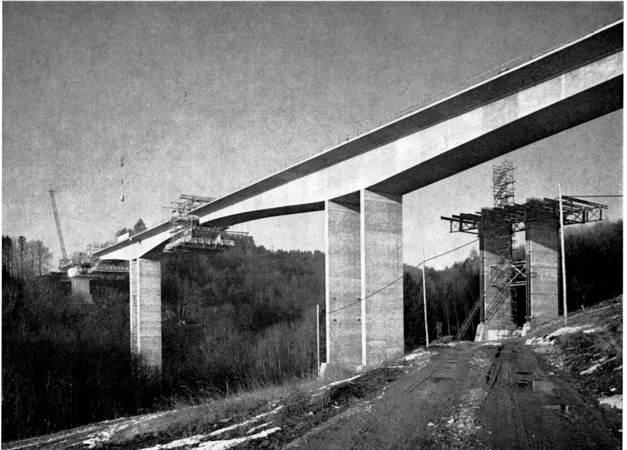
Fig. 3 Vue du pont aval: portique 3 achevé, portique 2 à l'avant-dernier élément et, à droite, préparation de l'échafaudage à la pile 103
