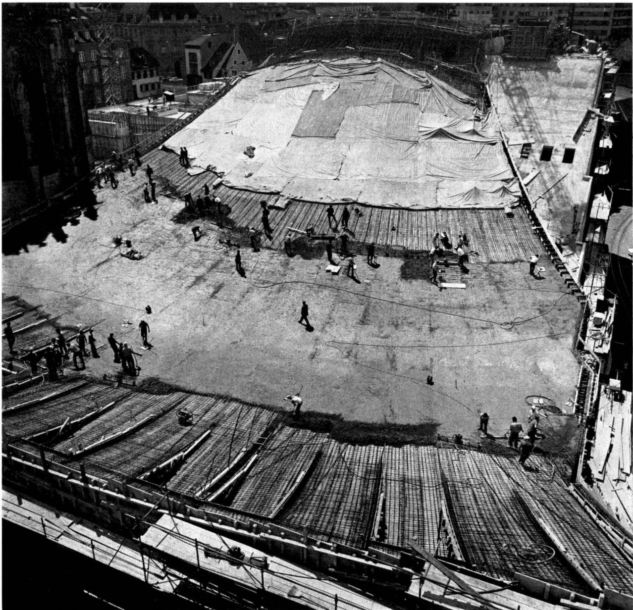
Abb. 1 Ausführungsstand nach ca. 4 Stunden Betonierzeit.
