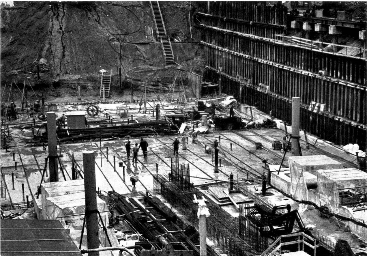
Abb. 2 Draufsicht auf die Bodenplatte mit eingebauten Auftriebsankerreihen
