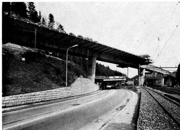
Abb. 4 Ansicht mit Konsol-Schalwagen
