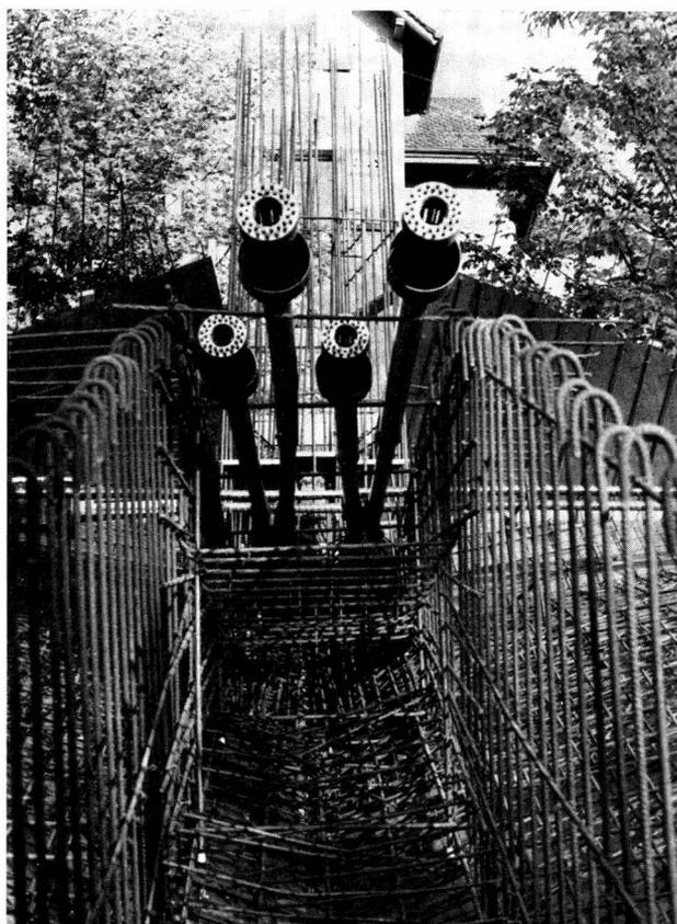
Fig. 2 Armature des nervures avec la position des accouplements
