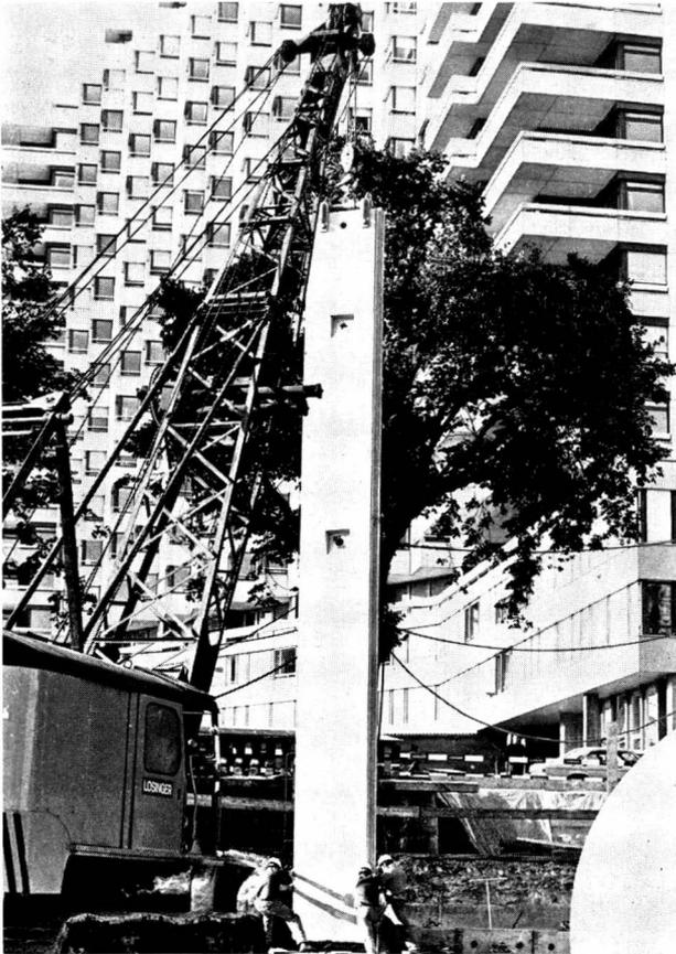
Abb. 4 Versetzen eines Elementes. Im Hintergrund das Bettenhochhaus
