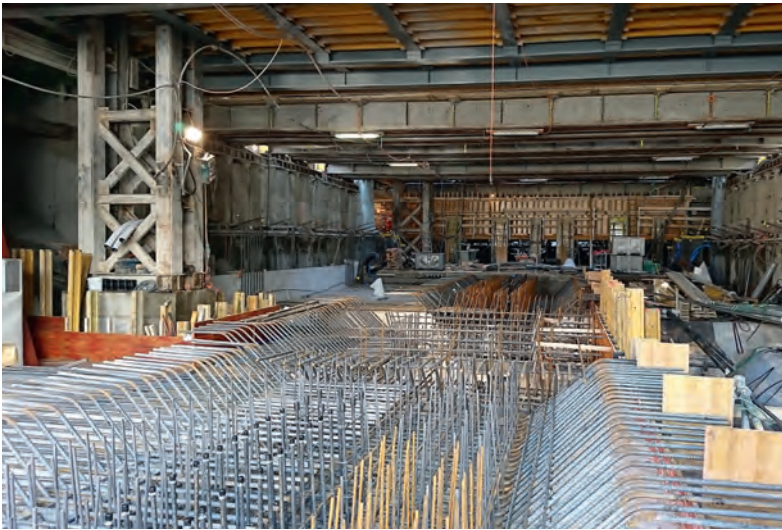
Fig. 8 Armierung der Bodenplatte unter den Gleis- und Perronhilfsbrücken. Reinforcement of the bottom slab under the auxiliary track and platform bridges.
