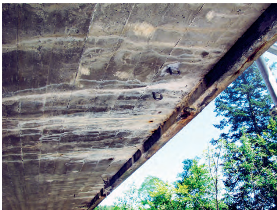
Fig. 3 Dégradations avant travaux sous les porte-à-faux. Deterioration before work, under the cantilevers.
