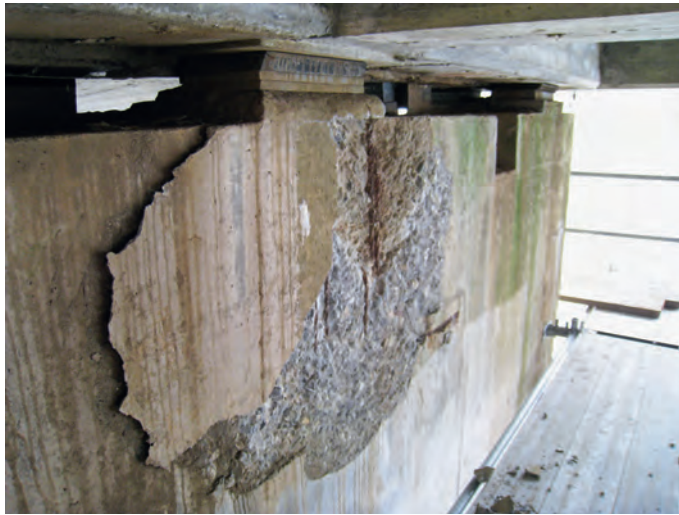
Fig.3 Grossflächige Abplatzung bei Stütze C. Extensive spalling at support C.
