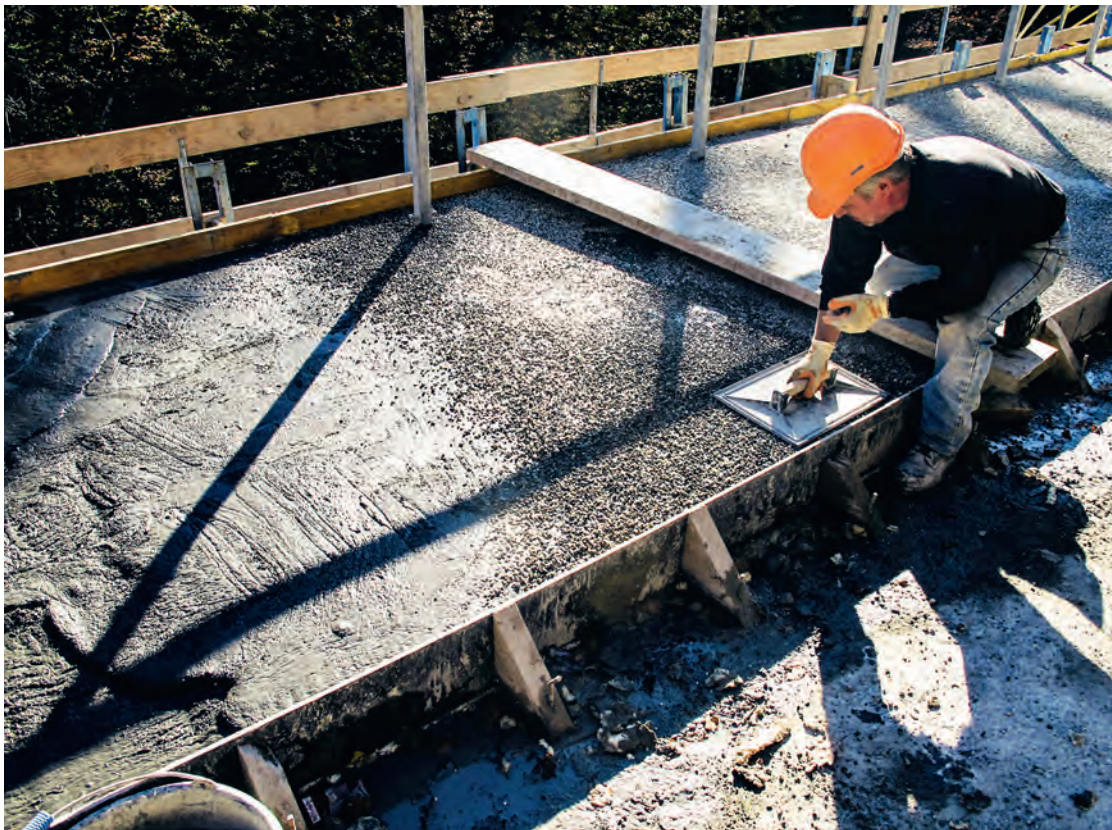
Fig. 6 Mise en place du BFUP et gravillonnage. Installing the UHPFRC and gravelling.
