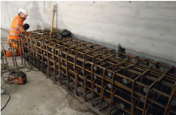
Fig. 7 Bewehrung des Verankerungsblocks der externen Vorspannung. Reinforcement of the anchor block of external prestress.
