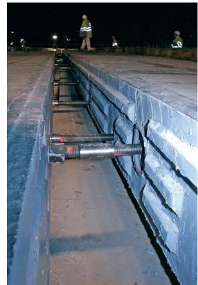
Fig. 7 Pose d'un nouvel élément dans la trémie – collage époxy et post-tension des éléments à joints conjugués. Laying a new element in the opening – epoxy sealing and post-tensioning connection against the previous one.
