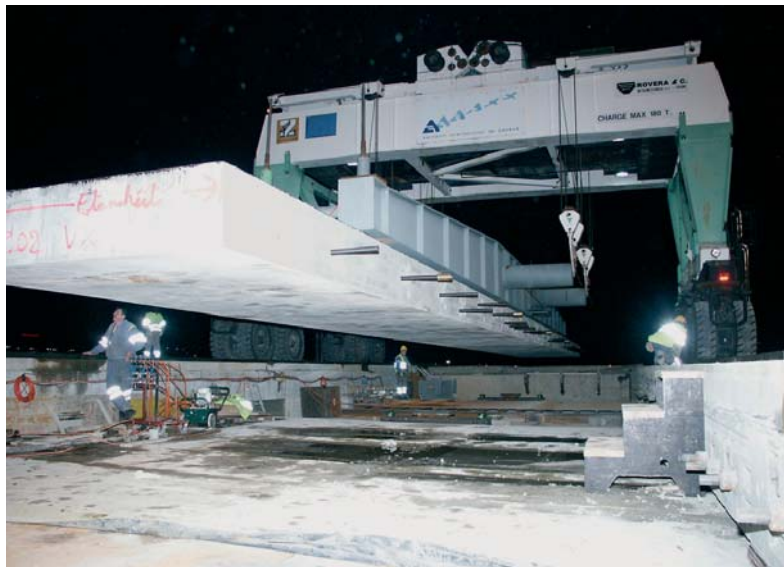
Fig. 7 Pose d'un nouvel élément dans la trémie – collage époxy et post-tension des éléments à joints conjugués. Laying a new element in the opening – epoxy sealing and post-tensioning connection against the previous one.
