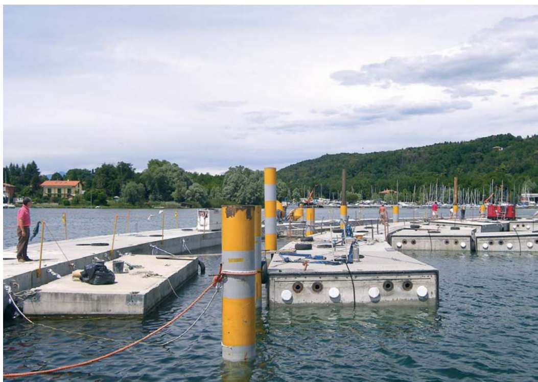
Fig. 2 Ultime operazioni di accoppiamento dei gruppi formati da tre moduli. Last connecting operations of the units formed of three modules.
