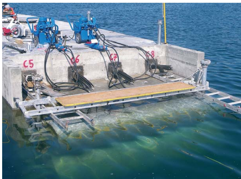
Fig. 4 Impiego di due martinetti monotrefolo. Use of two single strand jacks.
