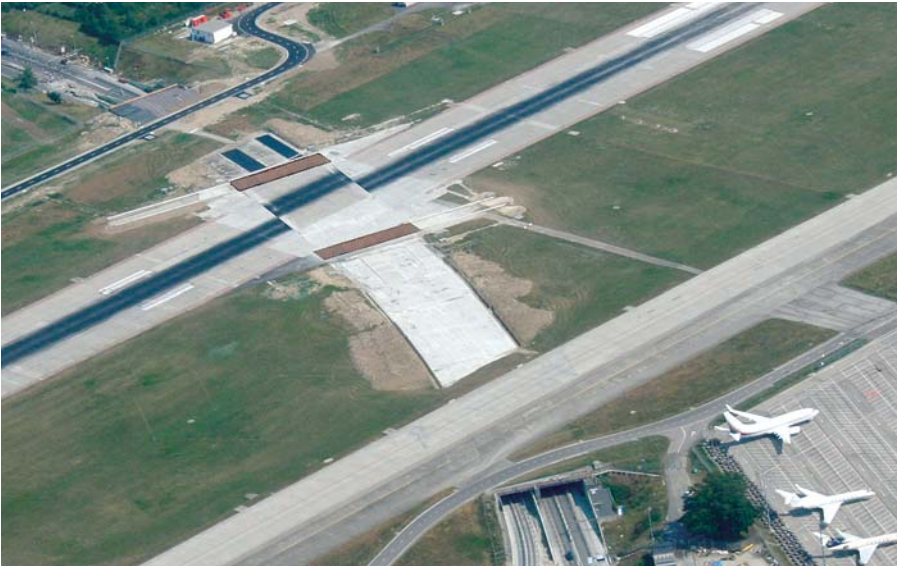
Fig. 8 Vue de la piste après 3 étapes de ripage. View of the runway after 3 pushing steps.
