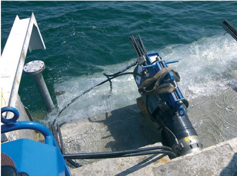
Fig. 5 Impiego di un martinetto multitrefolo. Use of a multi strand jack.
