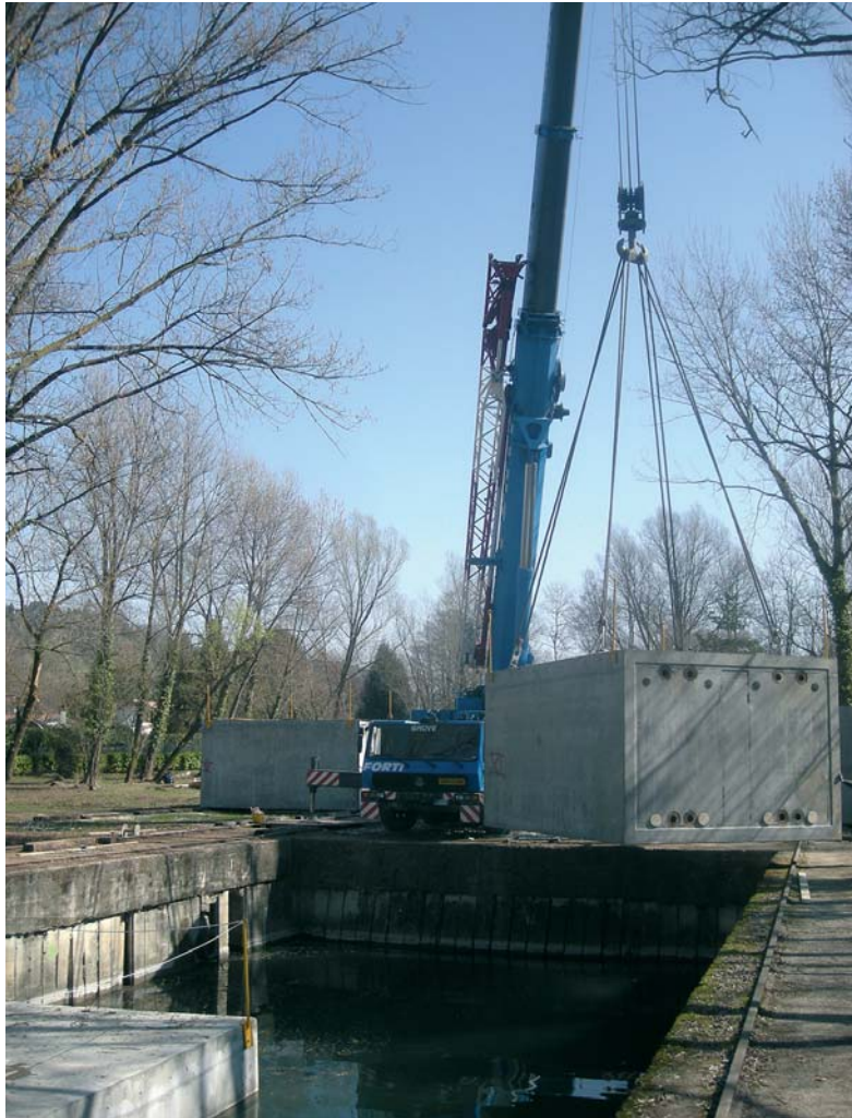
Fig. 1 Messa in acqua dei moduli per mezzo di un autogrù. Placing in the water of the modules by means of mobile crane.
