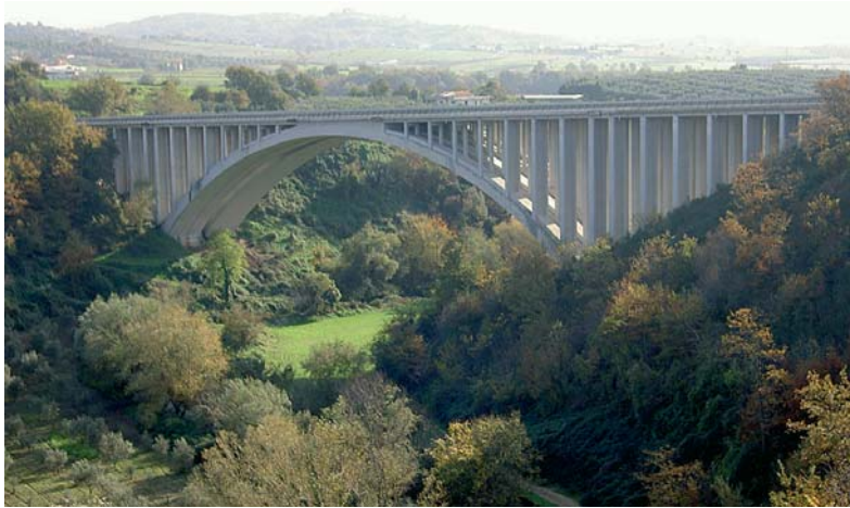
Fig. 1 Vista del ponte Tenza. Tenza bridge view.
