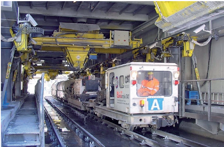
Betonbezug unter der Mischanlage Concreting train under the batching plant
