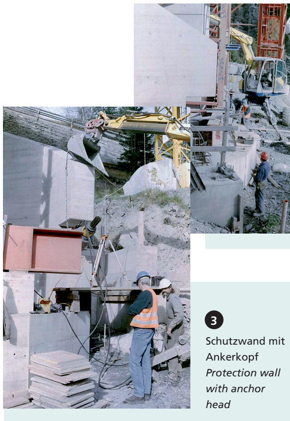
Pfeilerfuss mit Schutzwand im Vordergrund Base of bridge pier with protec- tion wall in the foreground
