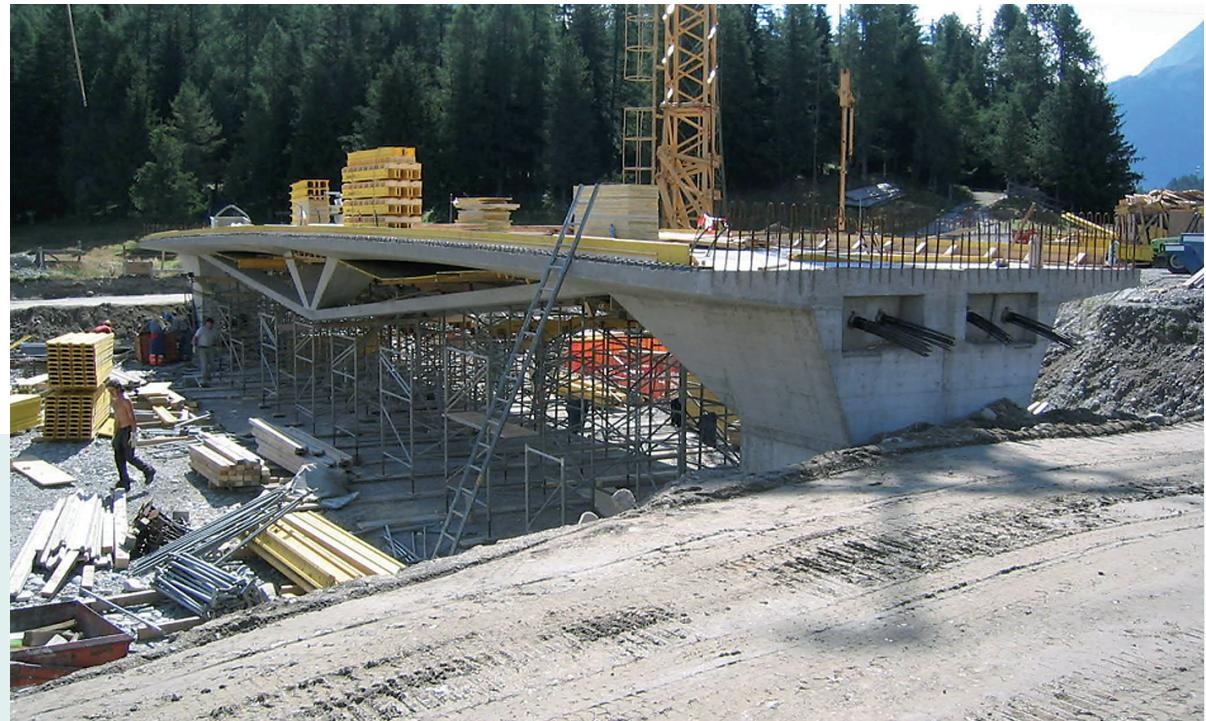
La sezione trasversale della piattaforma è massiccia di spessore costante nella parte centrale e rastremata in direzione dei cordoli (**figura 3**). Longitudinalmente lo spessore varia da un minimo di 25 cm al centro del ponte fino a ad un massimo di 50 cm nelle zone di connessione con le diagonali e le spalle.
