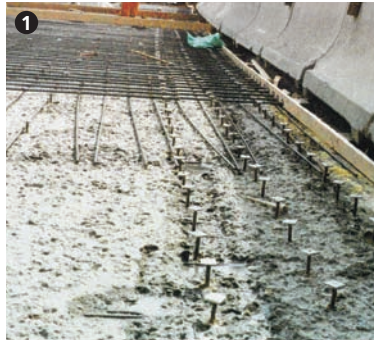
1 Instandsetzung einer Brücke mit Hilfe von Aufbeton. Bridge rehabilitation by means of concrete overlay.
