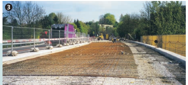
Vorbereitung der Brücke für Aufbeton. Preparation of bridge for overlay.
