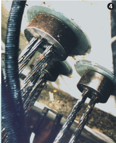
Elektrisch isolierte Spannverankerung. Electrically isolated stressing anchorages.
