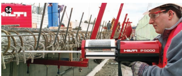
Injektion mit dem pneumatischen Injektionsgerät Hilti HIT-P 5000 HY. Injection by means of the pneumatic dispenser Hilti HIT-P 5000 HY.
