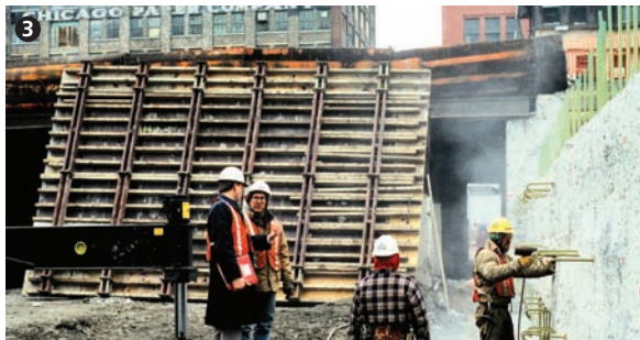
Tragwerkinstandsetzung. Structural upgrade.
