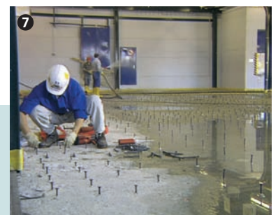
Verstärkung eines Industriegebäudes. Reinforcement of an industrial building.
