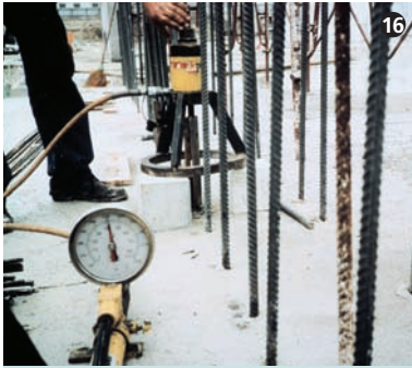
Prüfen des Verbundes. Site test for bond.
