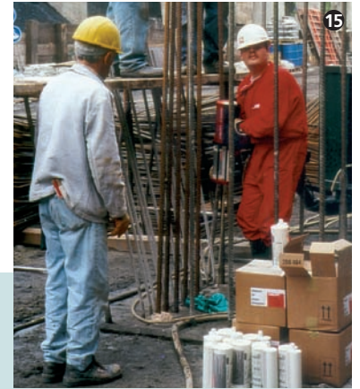
Setzen der Stäbe. Setting of the bars.
