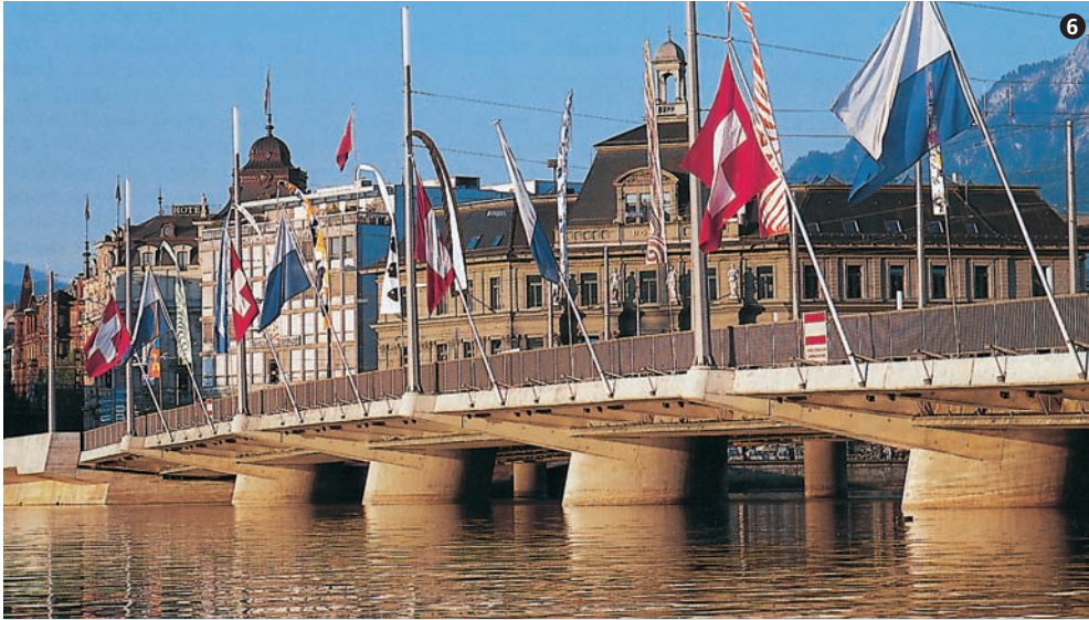
Seebrücke Luzern. Lake bridge Lucerne.
