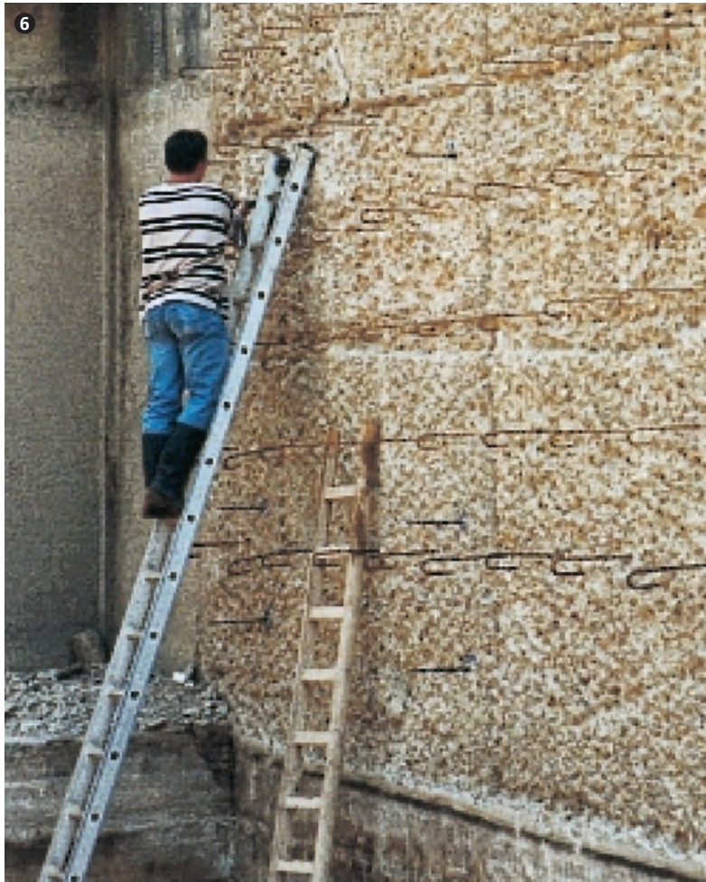
Erweiterung einer Kläranlage. Upgrade of water works.
