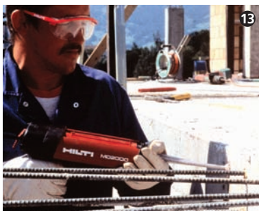
Injektion von Bohrlöchern mit Hilti HIT-Verbundmörtel. Injection of the pre-drilled holes using Hilti HIT-Adhesive.
