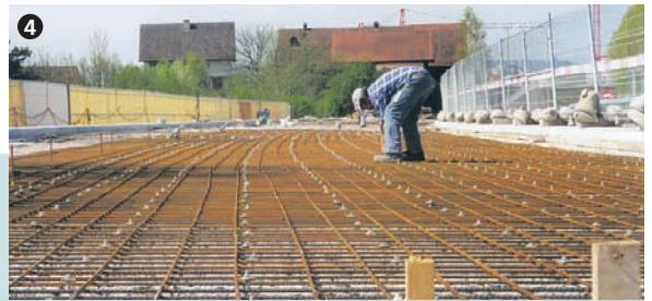
Setzen von Verbindern für Aufbeton. Placement of connector for overlay.
