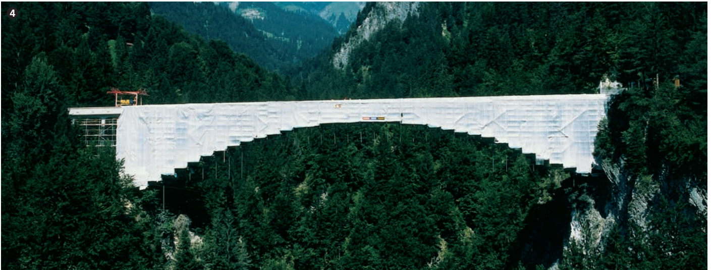
Eingehauste Brücke für die Spritzbetonarbeiten – wie ein Kunstwerk von Christo. Enclosed bridge for the shotcrete work – like one of Christo's works of art.
