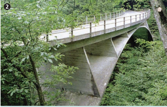
Schwandbachbrücke, versteifter Stabbogen mit gekrümmter Linienführung. Schwandbach bridge, horizontally curved deck-stiffened arch.
