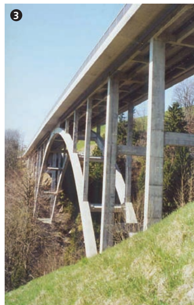
Vue du pont après l'intervention. View of the bridge after the intervention.
