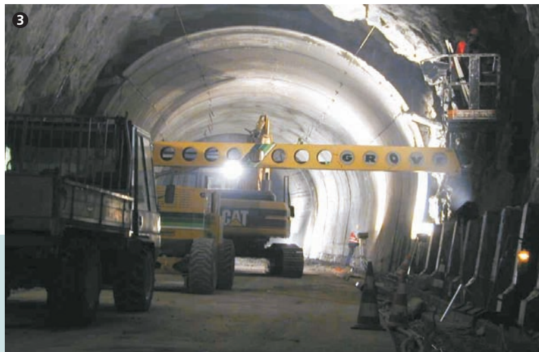
Abbruch der vorfabrizierten Betonelemente. Demolition of prefabricated concrete elements.
