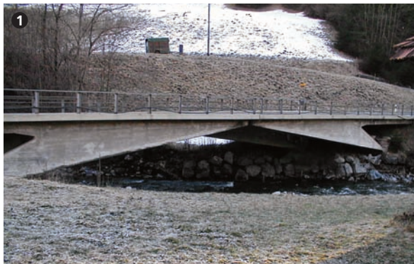
Garstattbrücke mit zwei einzelnen, in Längsrichtung versetzten dreigelenkigen Kastenbögen. Garstatt bridge with two single three-jointed box-arches staggered in the longitudinal.
