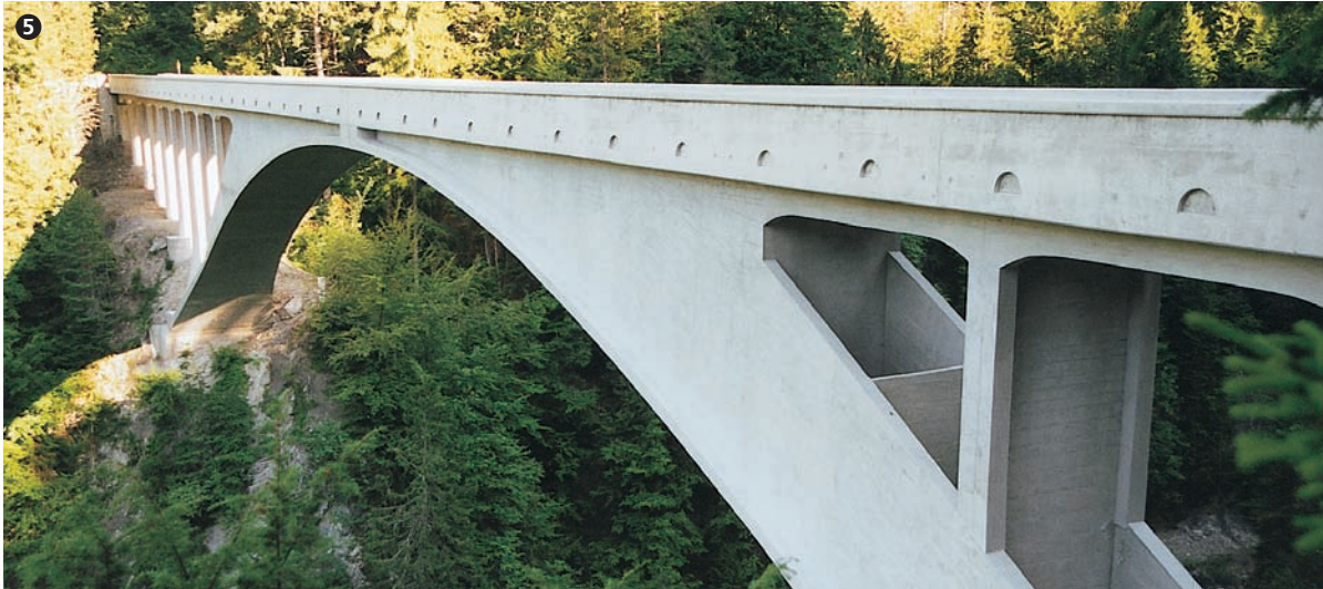
Die Salginatobelbrücke nach Beendigung der Erhaltungsmaßnahmen. The Salginatobel bridge after completion of the maintenance work.
