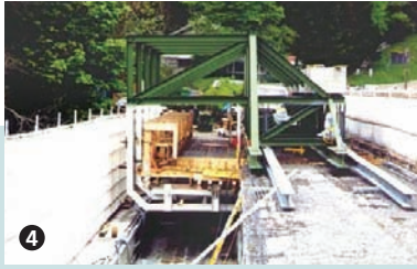
4 Bétonnage du tablier élargi. Pouring of concrete for the enlarged deck.
