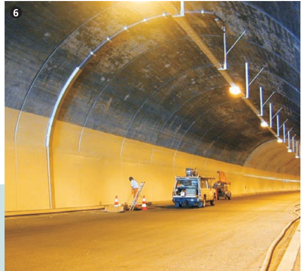
Abschlussarbeiten im Tagbaubereich. Finalisation work in cut and cover section.
