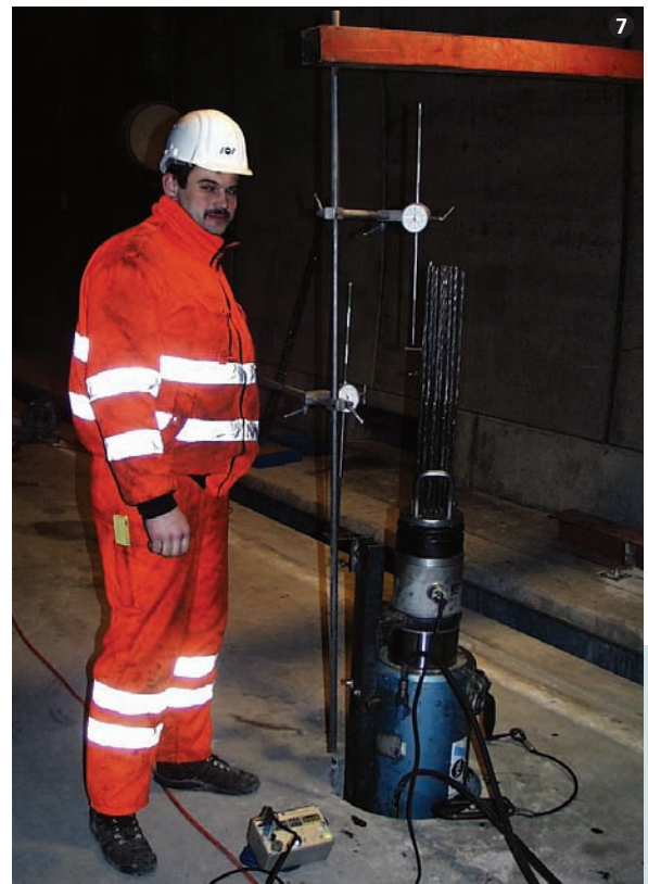
Spannen eines Versuchsankers. Stressing of a test anchor.
