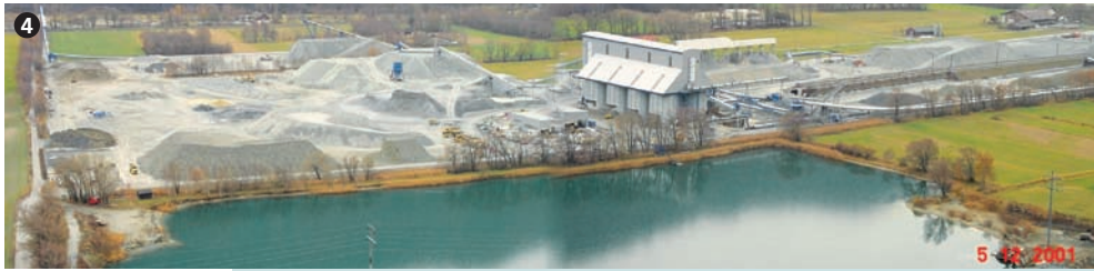
Kieswerk Raron. Raron gravel plant.
