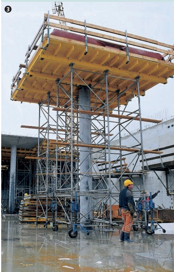
Vortrieb Deckenkonstruktion. Advancing of formwork.
