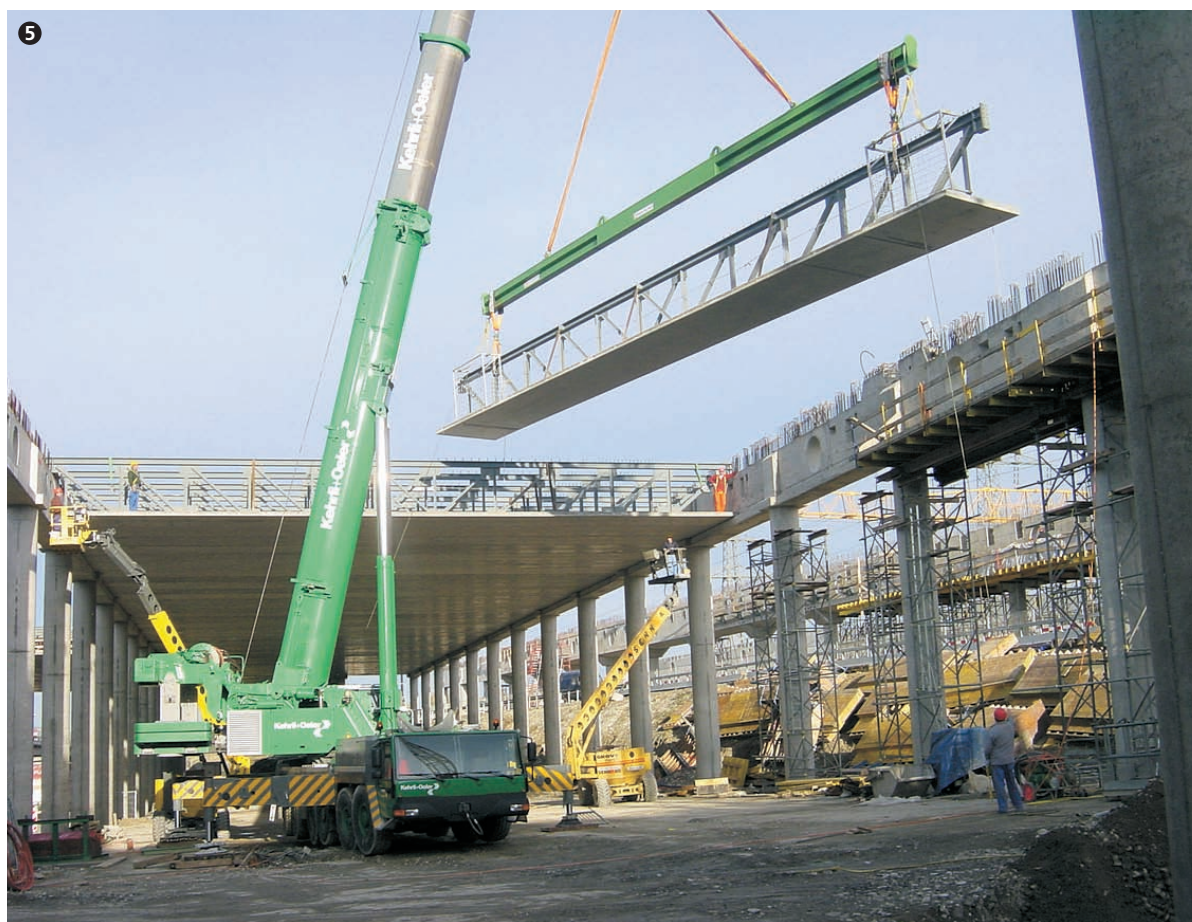
5 Montage type d'une poutre mixte. Erection of a prefabricated composite element.
