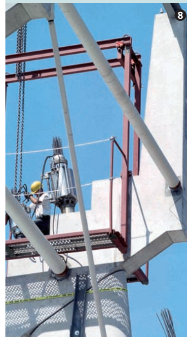
Vorspannen der Kabel. Post-tensioning of the steel cable.
