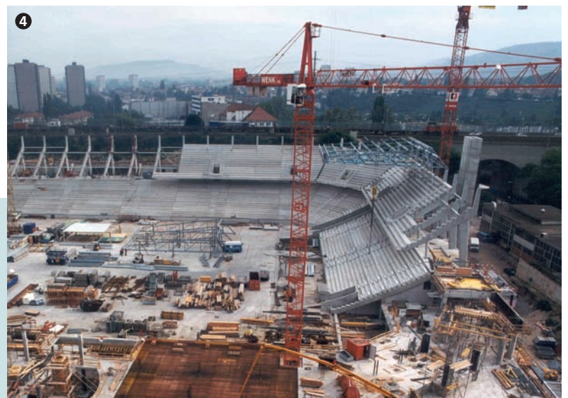
Zuschauertribünen während der Montage. Spectator area during erection.
