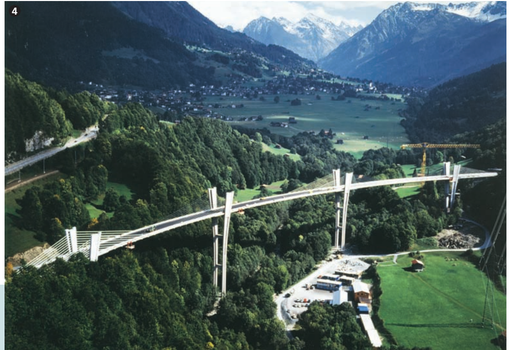
Gesamtansicht der Brücke. General view of the bridge.
