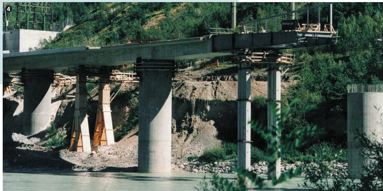
Piles provisoires et définitives du pont nord. Temporary and permanent piers of the north bridge.
