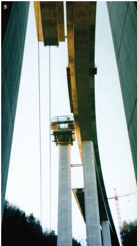
Vue inférieure de l'ouvrage en construction. View from bottom of the structure under construction.
