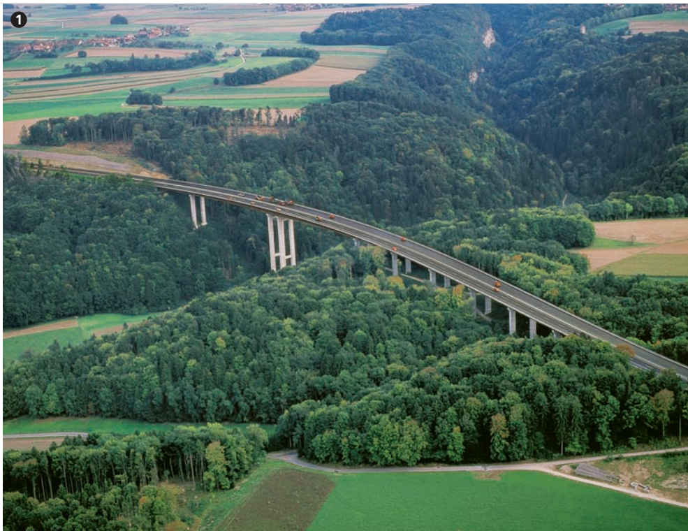
Vue aérienne de l'ouvrage. Aerial view of the bridge.
