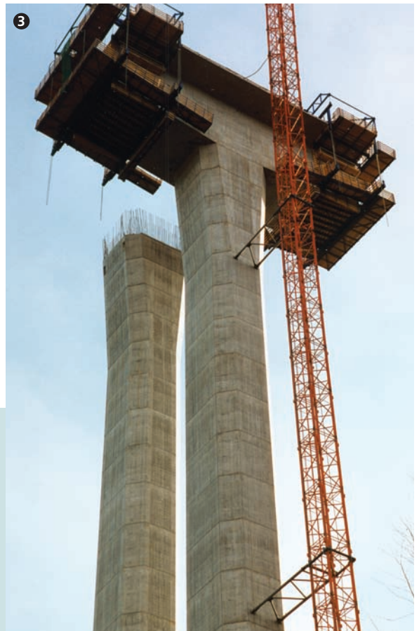
Têtes de piles détails. Detail of pier heads.
