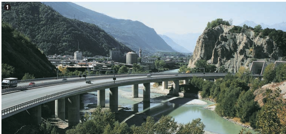
Vue générale du viaduc de l'Île Falcon. View of the Ile Falcon bridge.
