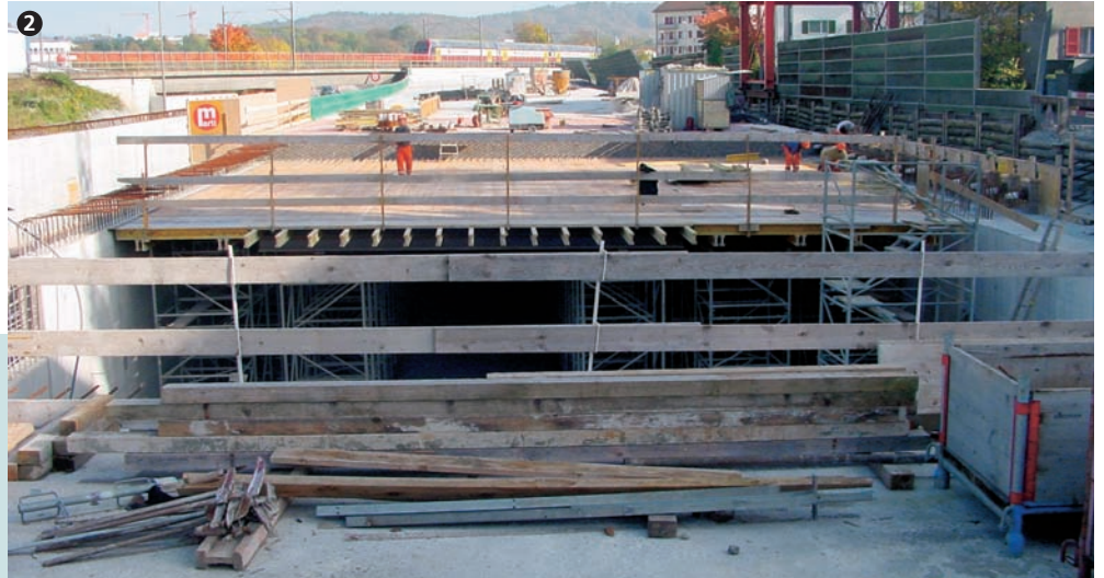
Blickrichtung Zürich mit Südspur, bereit zum Armieren. Looking towards Zurich with the south-carriageway, ready for reinforcement.
