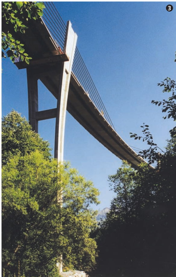
Blick von unten. View from underneath.
