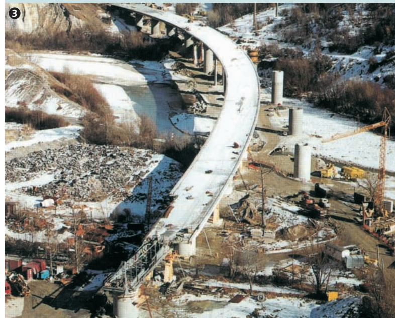
Vue générale du chantier pendant le poussage du pont nord. General view during execution of the north bridge.
