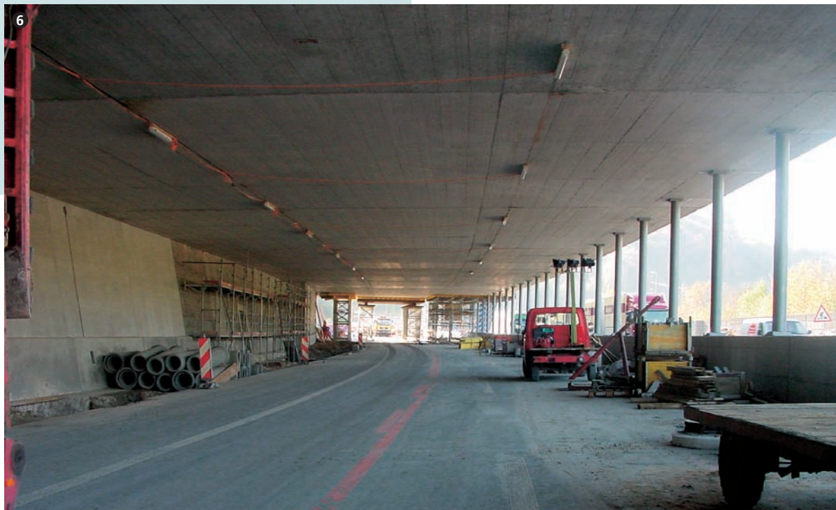
Betonierte Südspur im Galeriebereich. Concreted south-carriageway in the gallery area.
