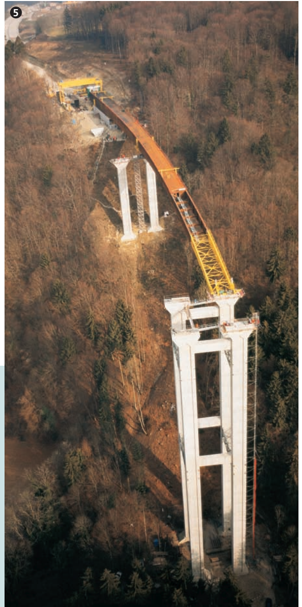
Vue aérienne de l'ouvrage durant l'opération de mise en place du tablier métallique.
