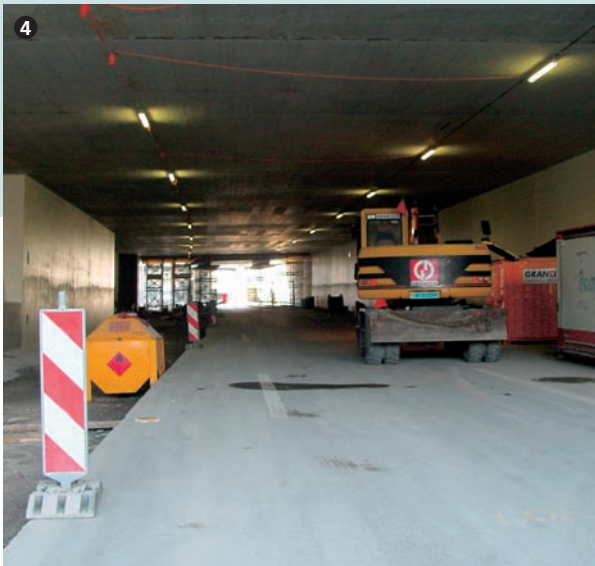
Betonierte Südspur im Tunnelbereich. Concreted south-carriageway in the tunnel area.
