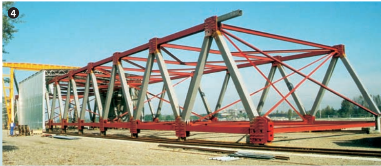
Raumfachwerk. Space truss.
