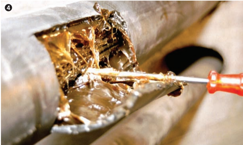
Hüllrohröffnung zur Überprüfung des Korrosionsschutzes vor dem Entspannen. Opening of the duct to check corrosion protection prior to unstressing.
