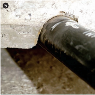
5 Kritischer Bereich des Spannglieds vor der Auswechslung. Critical part of the tendon prior to replacement.
