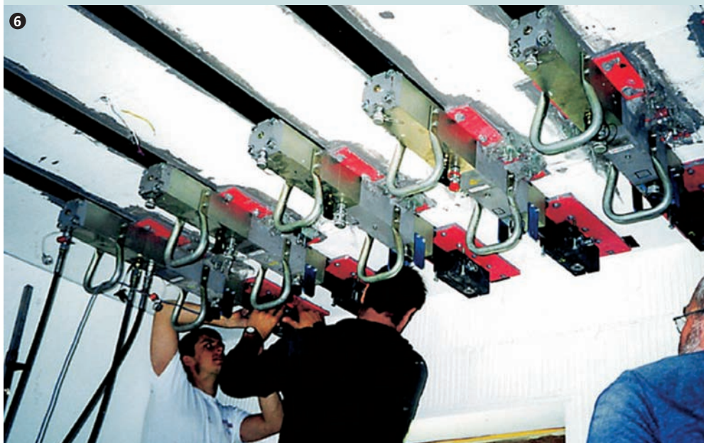
Verstärken einer Stahlbetondecke mit vorgespannten CFK-Lamellen. Strengthening of concrete slabs with prestressed CFRP strips.
