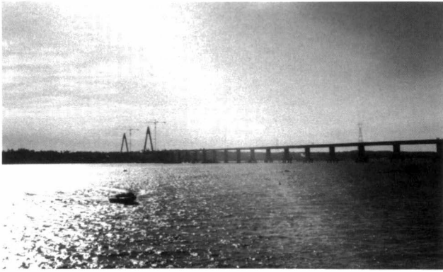
Fig. 15. Gesamtansicht des Brückenzuges vom argentinischen Ufer aus gesehen – Vue d'ensemble de la structure du pont, prise depuis la rive argentinienne – General view of bridge structure seen from the Argentine bank
