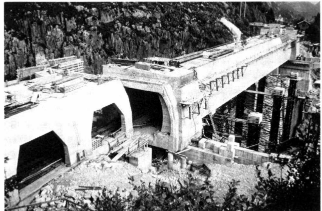
Fig. 10. Die Brücke nach dem ersten Querverschub. Ein Gleis auf der neuen Brücke in Betrieb – Le pont après le 1er cycle de ripage. Une voie en service sur le nouveau pont – Bridge after the first transverse pushing stage. One operational railway track on the new bridge
