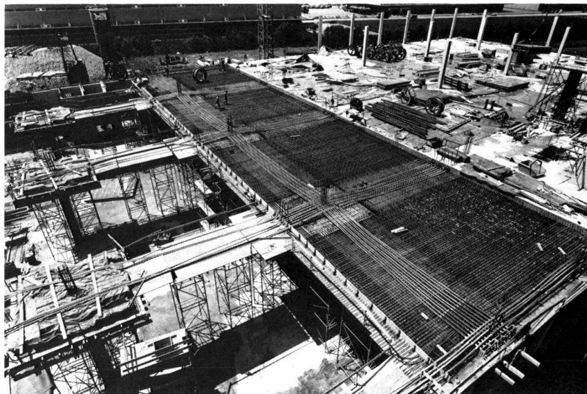
Fig.3. Ansicht einer Betonieretappe 15,40x56,40 m (obere Armierung noch nicht verlegt) – Vue d'une étape de bétonnage de 15,40x56,40 m. (L'armature supérieure n'a pas encore été mise en place). – Overall view of the concreting of a 15.40 m x 56.40 m slab section (The upper reinforcement has not yet been placed)
