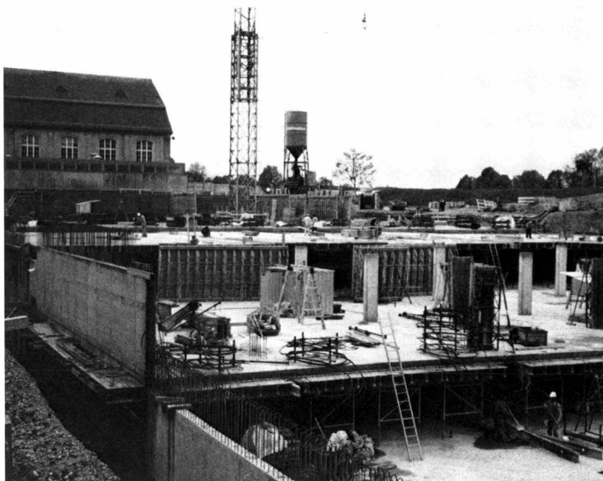
Gestaffelter Baufortschritt auf 3 Ebenen – Construction par étapes sur 3 niveaux – Staged construction on 3 different levels
