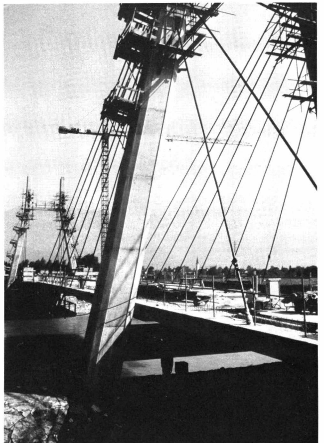
Fig. 15. Diepoldsau bridge (Switzerland). First cable stayed bridge with slender deck ever built - Pont de Diepoldsau (Suisse). Premier pont haubané à tablier mince à avoir été réalisé - Brücke Diepoldsau (Schweiz). Erste Schrägseilbrücke mit schlanker Fahrbahnplatte
