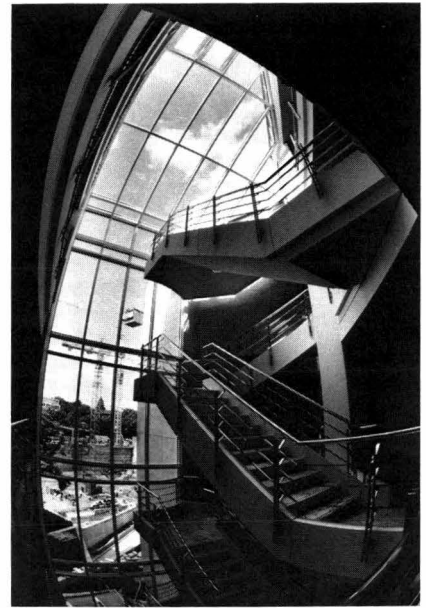
Fig. 2. Freitragende Treppe im Atrium – Atrium avec escalier en porte-à-faux – Atrium with cantilevered stair
