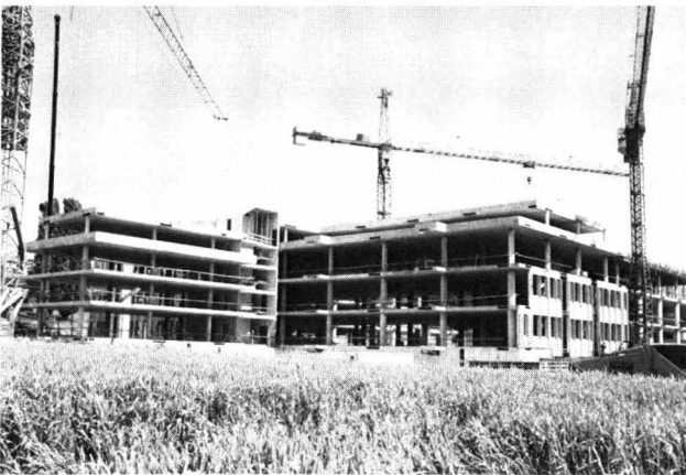
Fig. 3. Ansicht der Tragkonstruktion, Block A, B und D – Vue d'ensemble de la structure porteuse. Blocs A, B et D – Overall view of supporting structure, blocks A, B and D.
