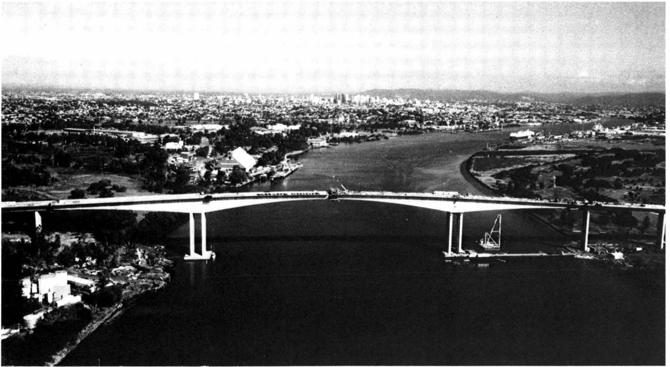
Fig.3. Das Bauwerk kurz vor dem Fugenschluss im Hauptfeld (Juli 1985) – L'ouvrage peu avant le clavage de la travée principale (Juillet 1985) – The structure just before closure of the main span (July 1985)
