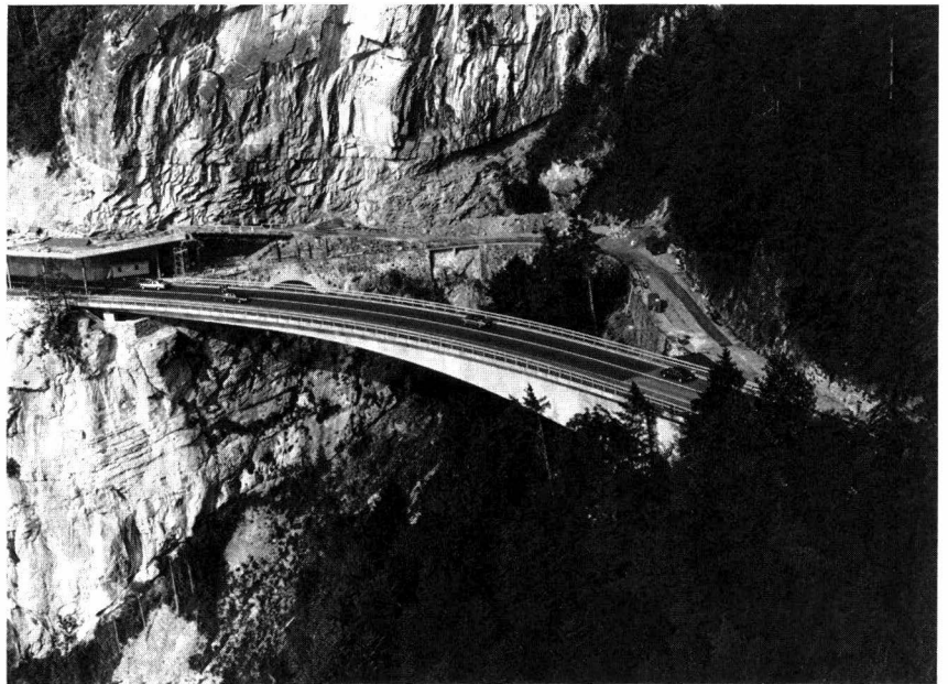
Fig.4. Ansicht der fertigen Brücke – Vue du pont achevé – View of completed bridge
