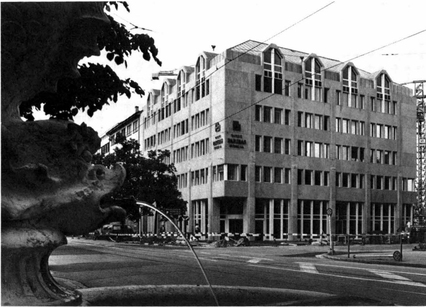
Fig. 1. Ansicht Ecke St. Jakobsstr./Gartenstr. – Vue du coin St. Jakobsstr./Gartenstr. – View from St. Jakobsstr./Gartenstr.
