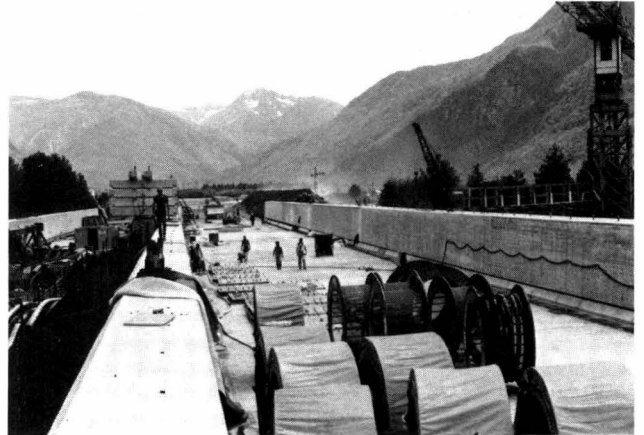
Fig. 8. Sicht auf Nord-Süd Fahrbahn – Vue de la chaussée nord-sud du pont – View of north-south carriageway – Vista carreggiata nord-sud
