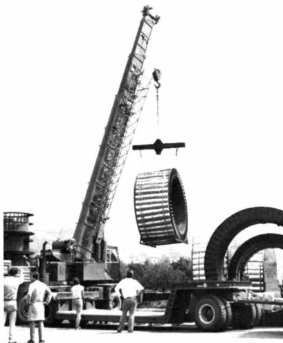
Fig. 9. Auflad einer Transportbobine auf Tiefganganhänger – Chargement d'une bobine sur remorque surbaissée – Loading of a cable reel onto low-bed trailer
