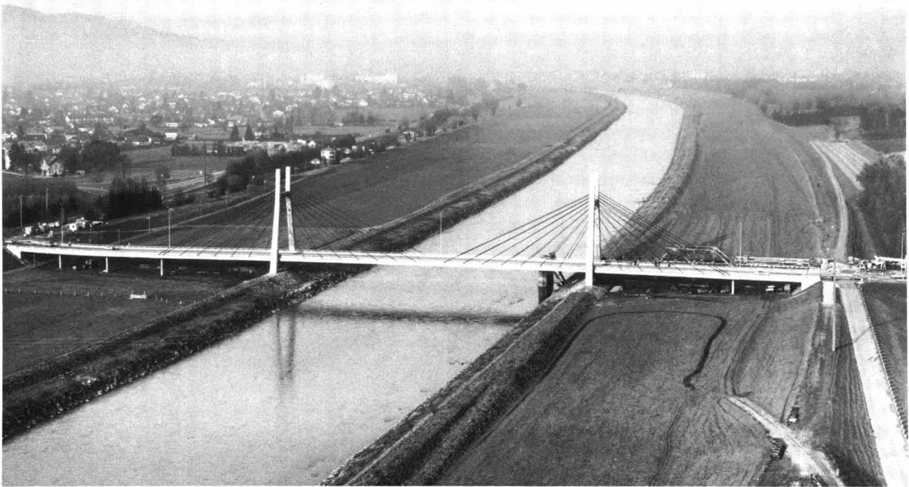
Fig. 6. Ansicht der neuen Brücke Diepoldsau. Die alte Brücke ist beinahe abgebrochen – Vue du nouveau pont de Diepoldsau. Le vieux pont est presque totalement démoli – View of new Diepoldsau bridge. The former bridge is almost completely demolished (Photo Cornet, 4.12.1985)
