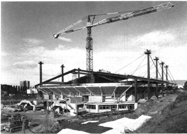
Fig. 3. Roof during the erection – Toiture en cours de montage – Bedachung während der Montage
