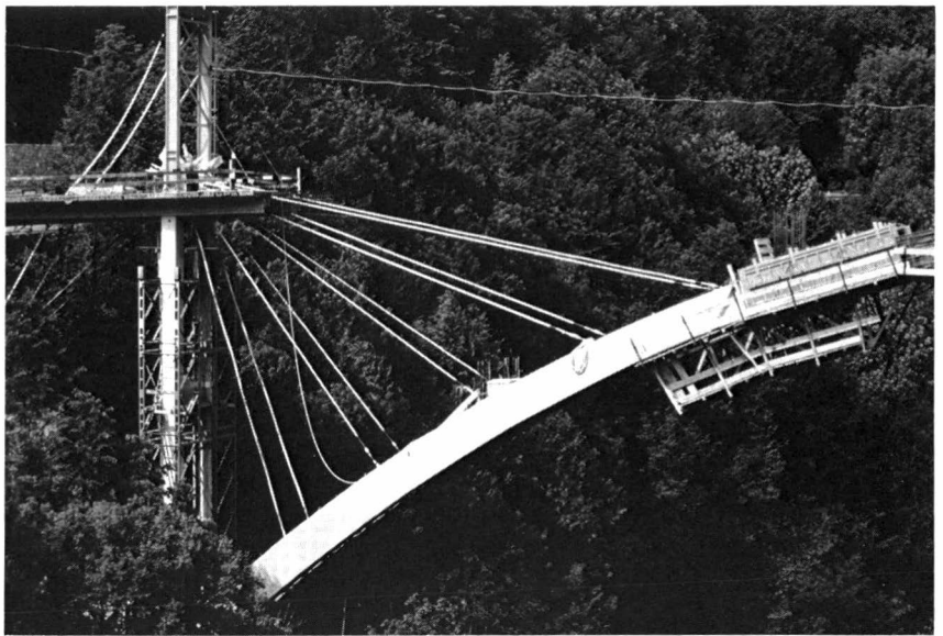
Fig. 3. Bauzustand – Phase d'exécution – Construction stage
