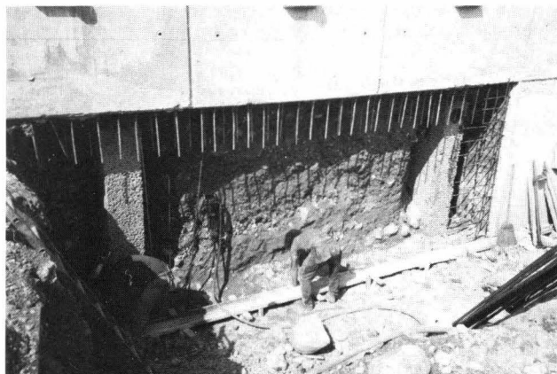
Fig. 5. Bauzustand mit vertikaler Drainage. Vorbohren der Löcher für vertikale Anschlussarmierung – Phase d'exécution avec drainage vertical. Percage des trous pour le treillis de raccordement – Construction stage with vertical drainage. Drilling the holes for the connecting steel mesh
