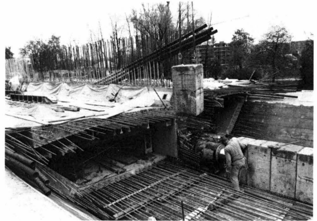
Fig.5. Produktionsstelle Widerlager Nord. Vorschieben mit Presse 720t – Lieu de production à la culée nord. Poussage en avant au moyen d'un vérin à 720 t – Production site at northern bridge bearing. Pushing by means of a propulsion jack at 720 t
